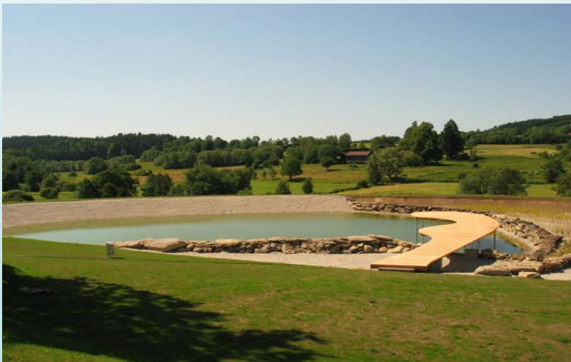
Frühsommer 2004: Kurz vor der Fertigstellung
