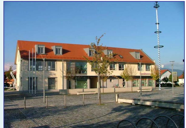
Außenansicht nach Fertigstellung
