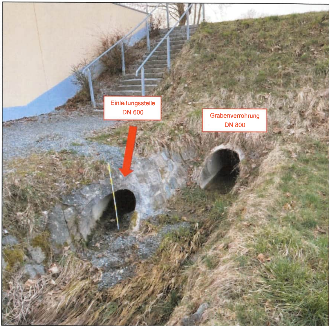
Abbildung 8: Foto best. Einleitungsstelle (Fl.-Nr. 478/4), DN 600 Sb
