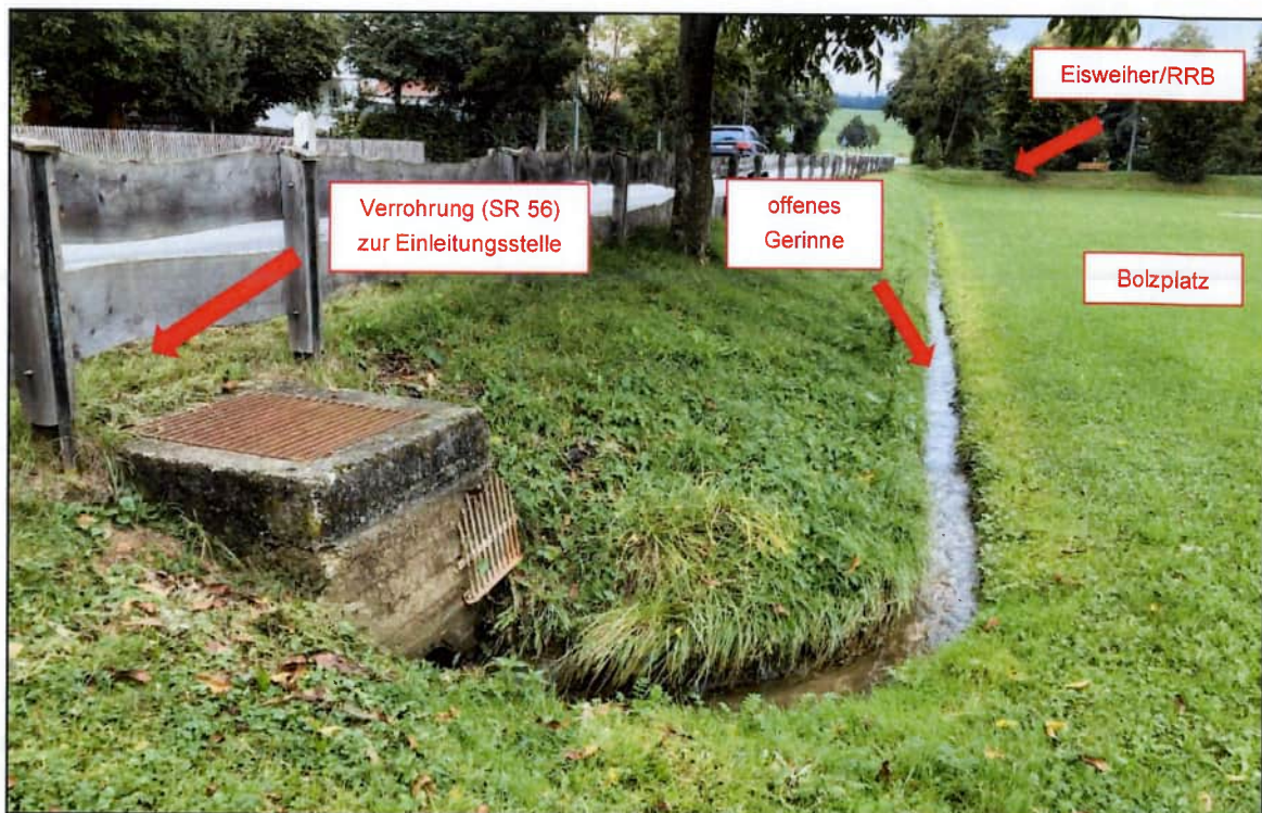
Abbildung 15: Foto Bestand offene Rinne in Richtung Einleitungsstelle
