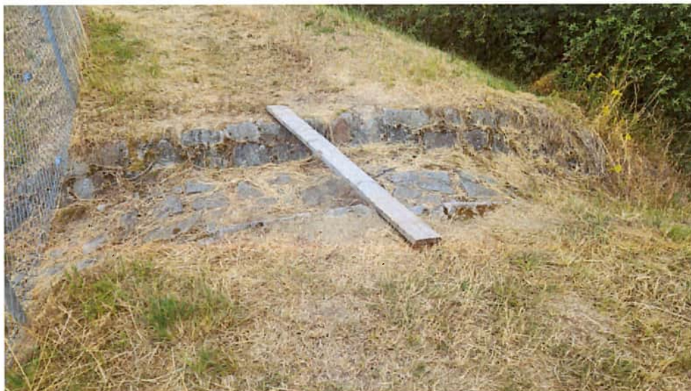
Abbildung 13: Notüberlauf des RRB 2 (Stand: Juli 2025)
