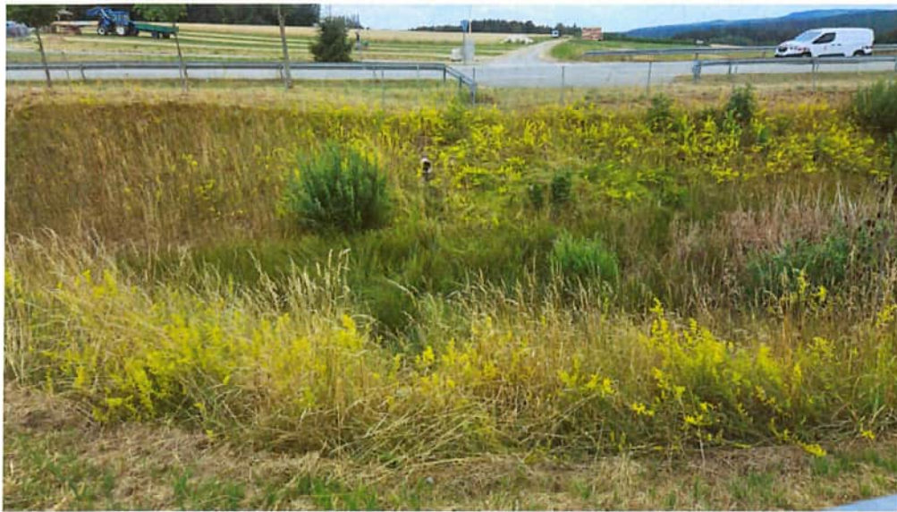
Abbildung 10: Vor-Ort Ansicht Regenrückhaltebecken RRB 2 (Stand: Juli 2025)
