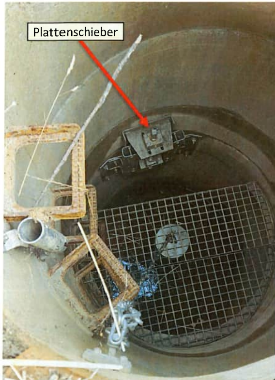
Abbildung 14: Schacht nach dem RRB 2 (Stand: Juli 2025)
