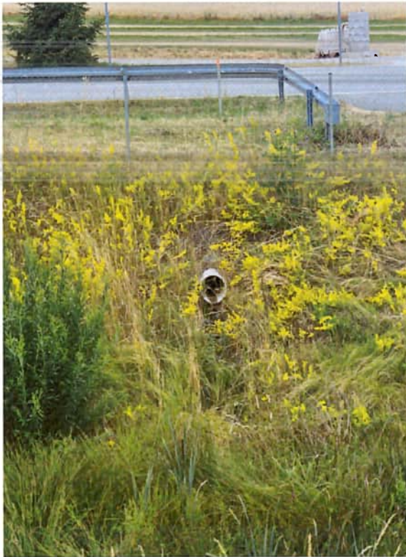
Abbildung 12: Zulauf von der Staatsstraße zum RRB 2 (Stand: Juli 2025)
