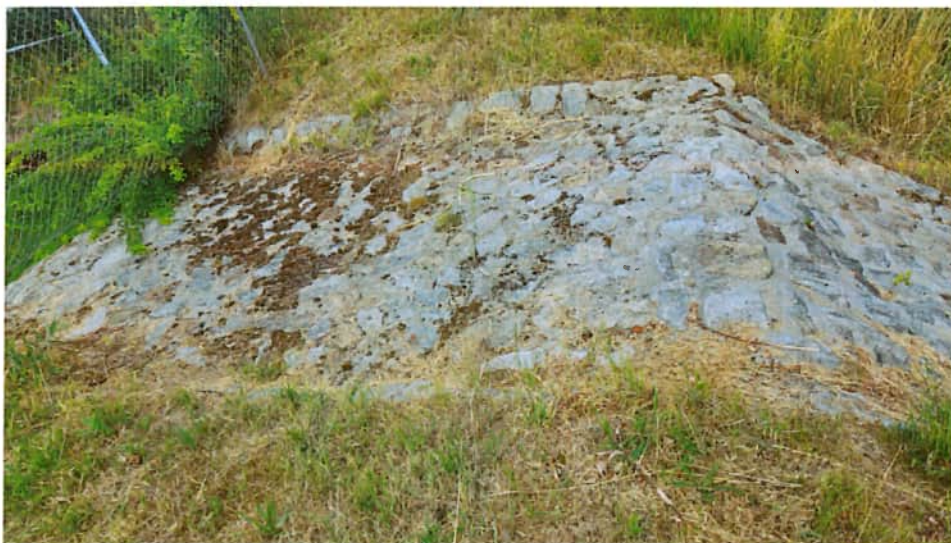
Abbildung 8: Notüberlauf des RRB 3 (Stand: Juli 2025)
