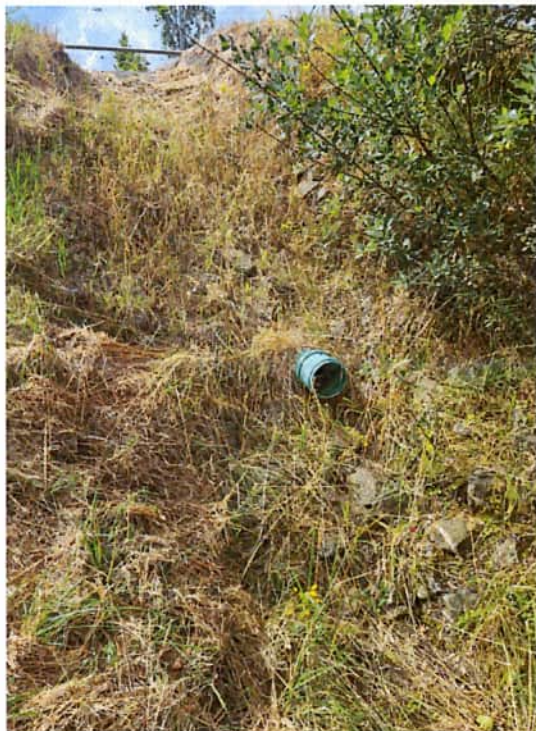
Abbildung 2: Einleitsstelle A 2 in den namenlosen Wiesengraben zum Furthbach mit einem Kunststoffrohr DN 150 (Stand: Juli 2025)
