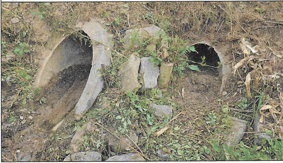
4 Zuläufe RRB 3 DN 600 und DN 500
