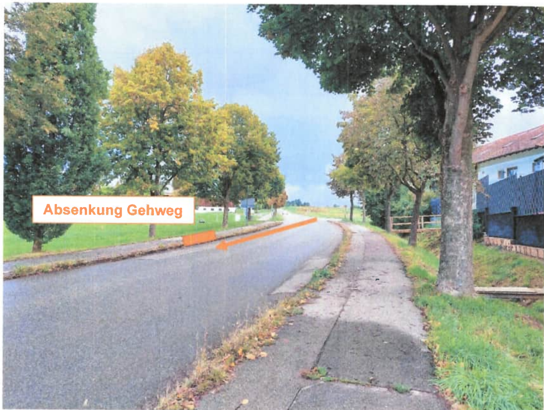
Abbildung 8: Absenkung Gehweg in Lintacher Straße (SR 4) für oberflächliche Ableitung Notüberlauf zum Europapark
