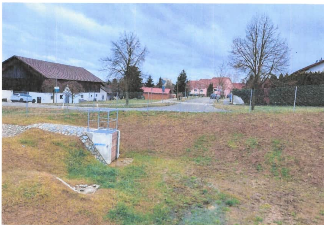
Abbildung 3: Regenrückhaltebecken RRB 4B mit Teichmönch und Notüberlaufmulde
