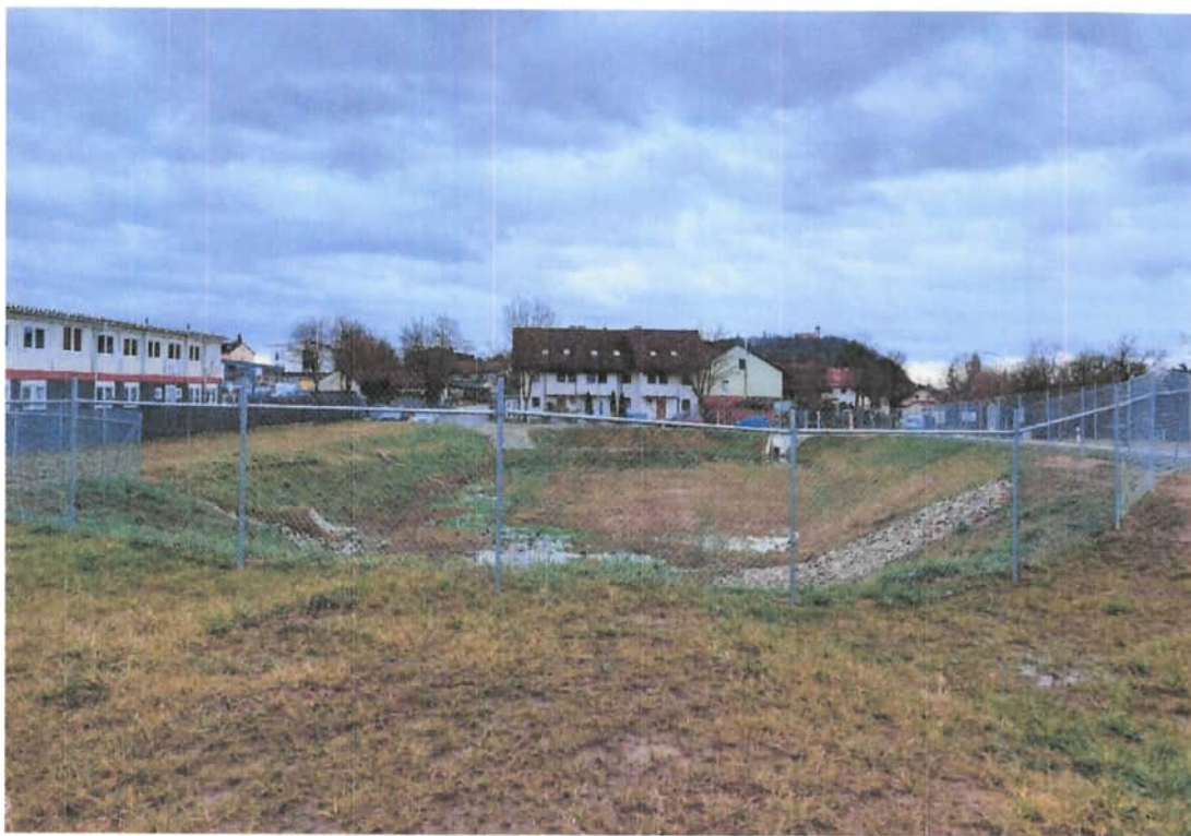
Abbildung 2: Regenrückhaltebecken RRB 4A mit Drosselschacht
