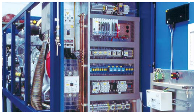
Ein Blockheizkraftwerk von innen
