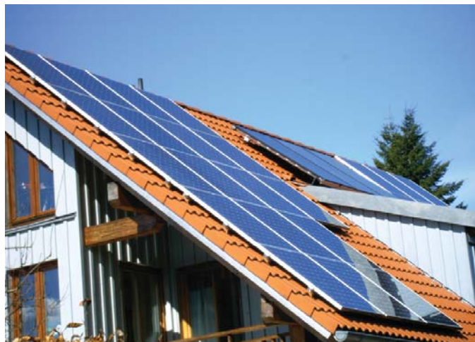
Fotovoltaikanlage auf dem Dach
