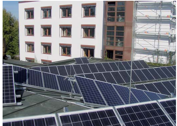
Solaranlage auf dem Dach des Sitzungssaals
