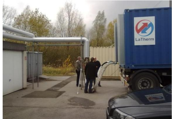
Abbildung 93: Latentwärmespeicher der Firma LaTherm (links: Entladeplatz an der Wärmesenke; rechts: Beladestation an der Abwärmequelle; Quelle: bifa Archiv)
