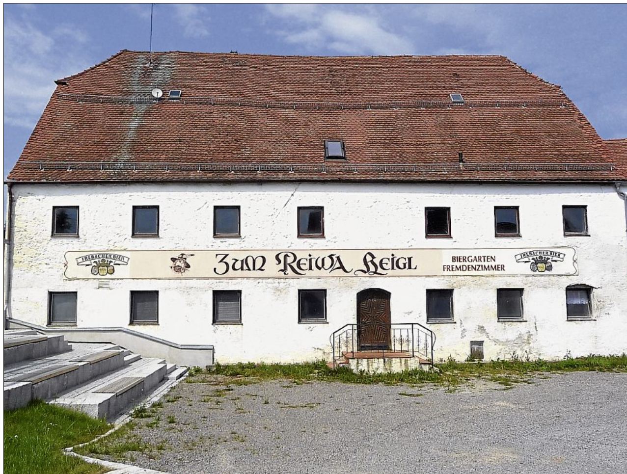
Das ehemalige Gasthaus am Ortseingang von Gschwendt könnte sich zum Lern- und Anschauungsort für Energiethemen entwickeln.
