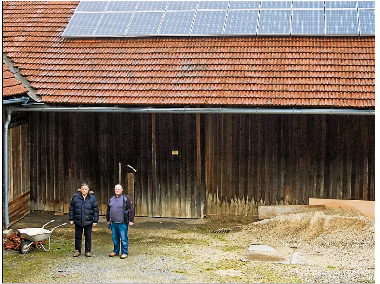
100 Module wurden auf den Dachflächen in Eschlbach installiert: Jedes Einzelne hat eine Leistung von 245 Watt. Auf dem Bild: Franz Hien und Alfons Eimer. (Fotos: privat)
