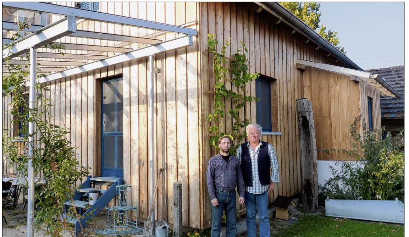
Vorher: Die ehemalige Hausfassade des 1954 errichteten Gebäudes mit den Kanthölzern, „Gerüst“ für den Thermohanf (Bild links) – Nachher: Jörg Bachinger und Baubiologe Peter Niedermeyer am Bachinger-Haus: Es ist mit Lärchenholz verkleidet und hat unten drunter die Unterlattung mit Kanthölzern, eine Thermohanf-schicht und Holzweichfaserplatten.
