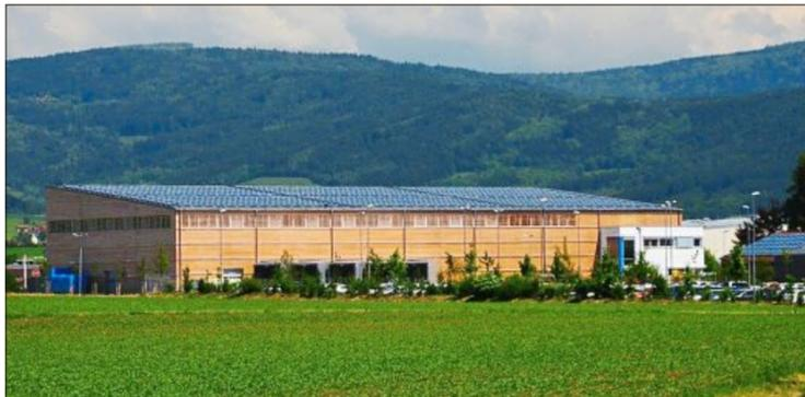
Das 2014 erbaute Logistikzentrum der Firma Dichtungstechnik Wallstabe & Schneider mit 3000 Quadratmetern Grundfläche ist eine komplette Holzkonstruktion, für die rund 725 Kubikmeter Holz (entspricht etwa 200 Bäumen) verarbeitet wurden. (Foto: Dichtungstechnik Wallstabe & Schneider)
