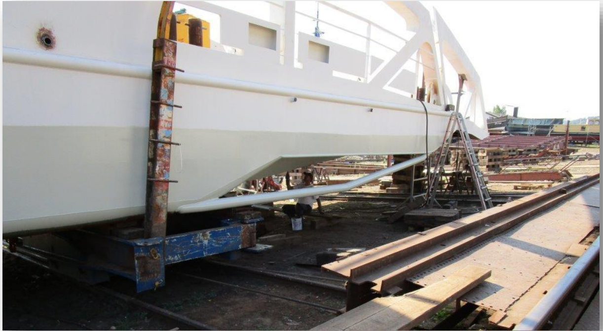
August 2017: Beginn der Bauarbeiten
